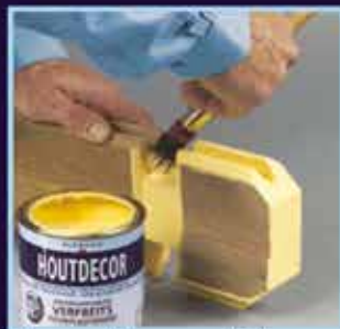
Extra aandacht voor verbindingen, messing en groef
